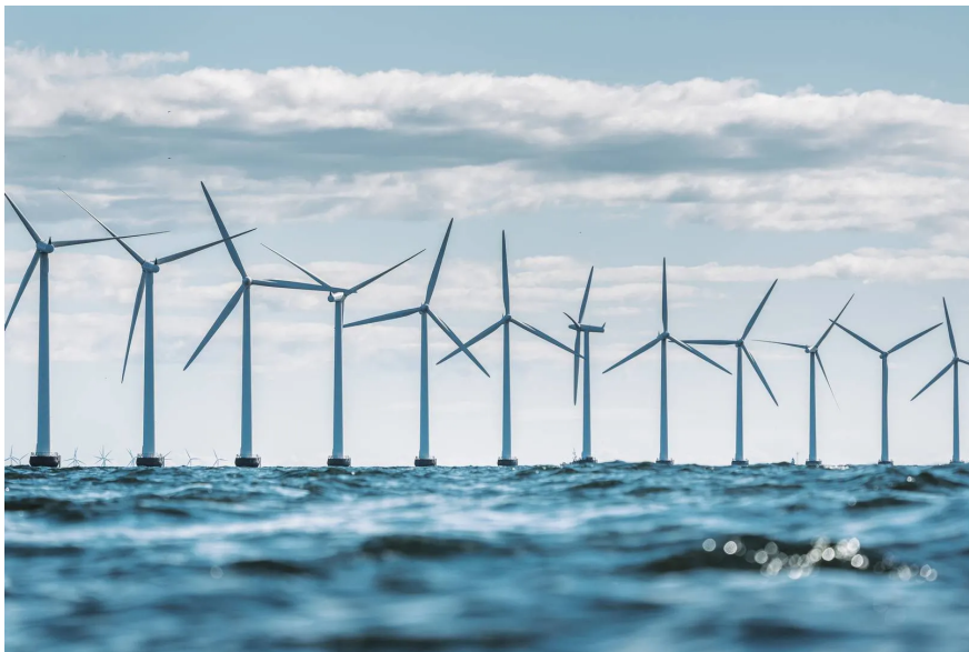
Parque eólico de EDP Renovaveis.
