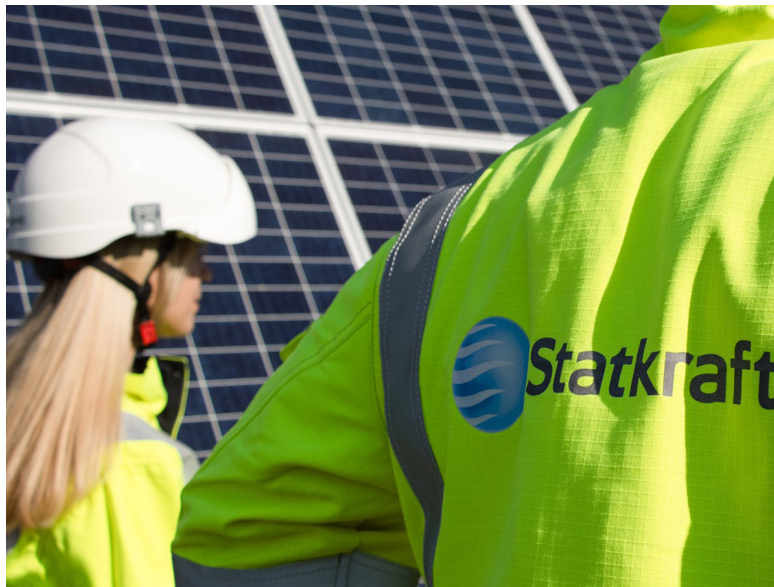
Operarios de Statkraft trabajan en la instalación de placas solares.
