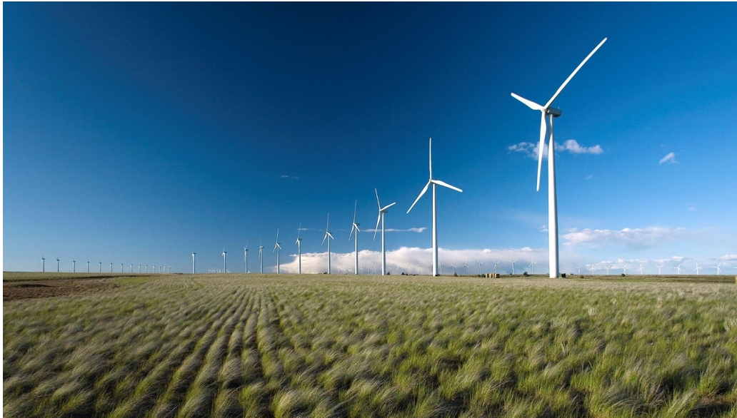
Parque eólico de Iberdrola.
