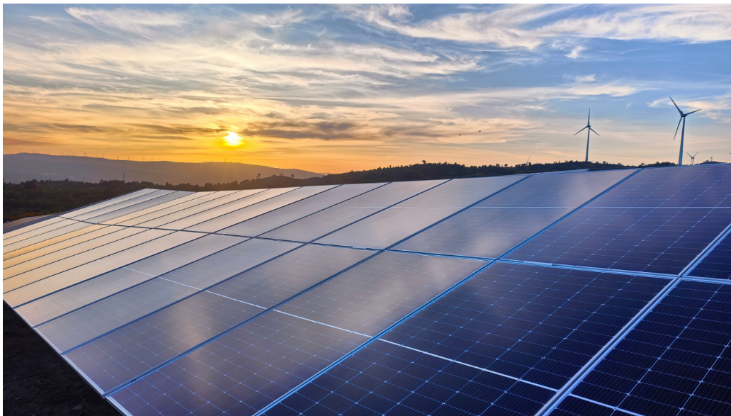
Sonneditx cierra la primera financiación en Portugal para proyectos híbridos de almacenamiento con baterías.
