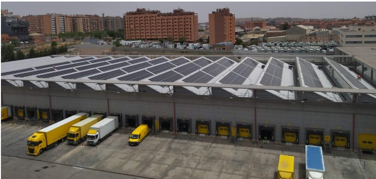
Instalación de placas solares de autoconsumo en centros logísticos
