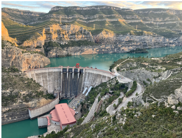
Central de Cortes-La Muela, la gran batería de Europa.
