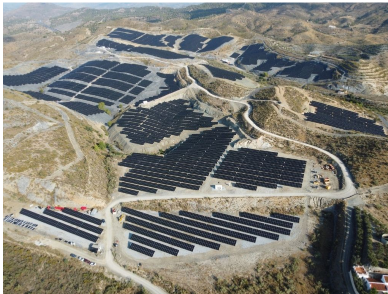
Negratín conecta a red la planta fotovoltaica Virgen del Rosario de 29,99 MWp en Motril (Granada).
