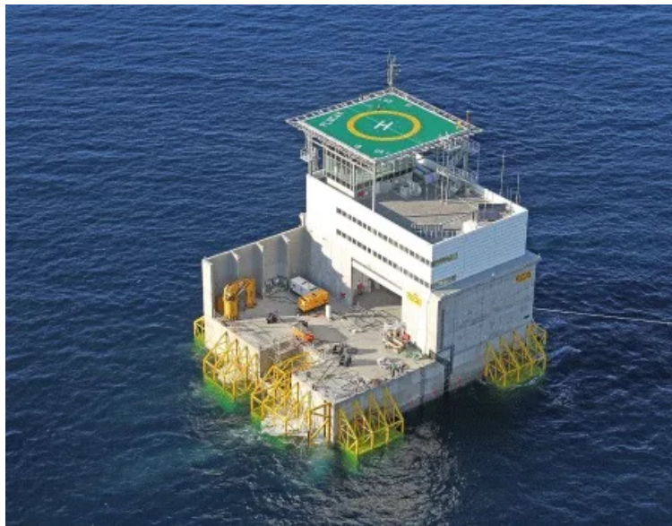
Plocan, o el "deliberado" hundimiento del buque insignia de la eólica marina Marca España
