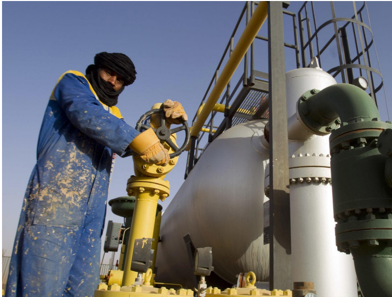
Instalaciones de gas en Argelia.
