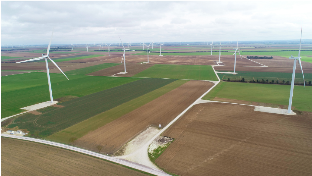
Econergy entra en Francia con la adquisición por 134 millones de euros de la plataforma eólica Escofi, de 740 MW
