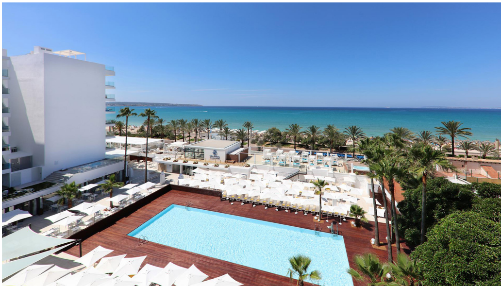
Iberostar y Redexis activan la primera pila de combustible de hidrógeno verde en un hotel.
