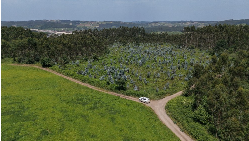
Red Eléctrica inicia las obras del Anillo eléctrico Central de Asturias con la subestación de Cardoso.
