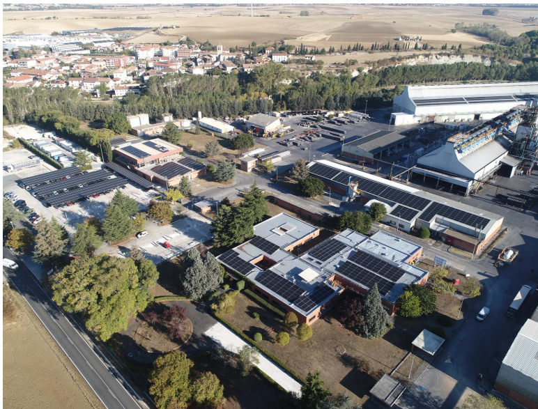
Acciona Energía instala un sistema de autoconsumo solar para descarbonizar la planta de Graftech en Navarra
