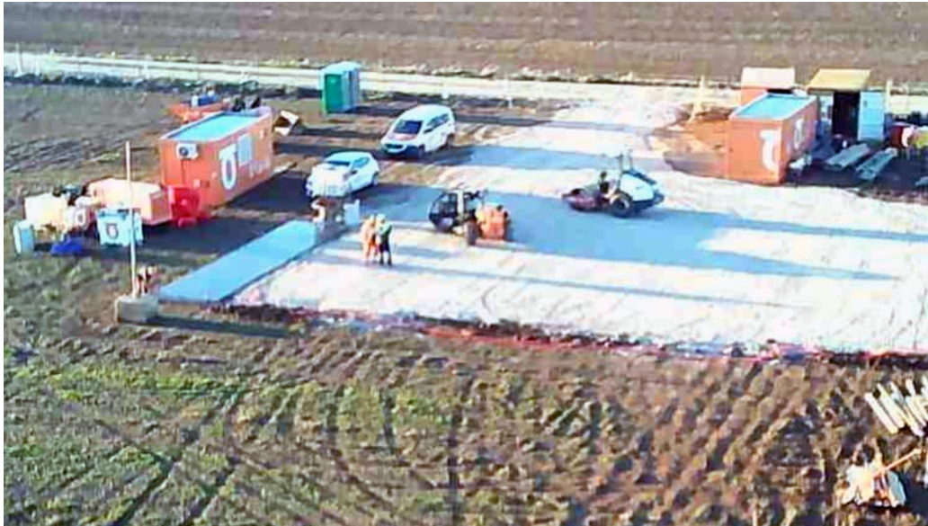
Red Eléctrica inicia las obras de la nueva subestación de La Sagra 400/220 kV que ayudará a que haya menos curtailments solares en la zona.
