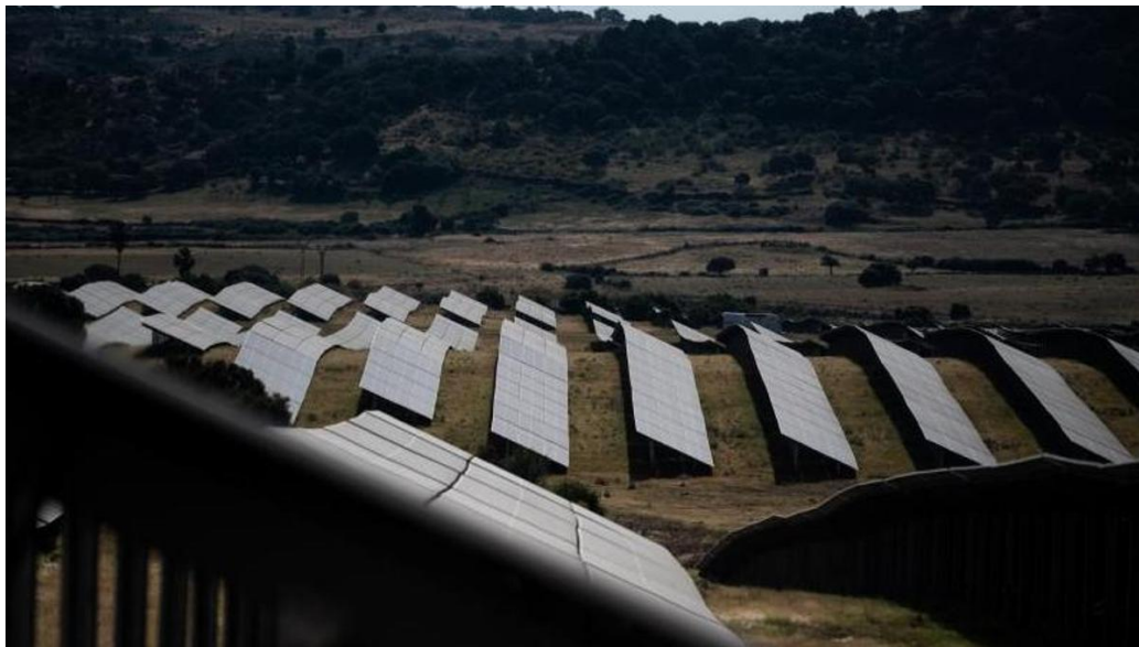
Placas solares de una instalación fotovoltaica situada en la provincia de Cáceres.
