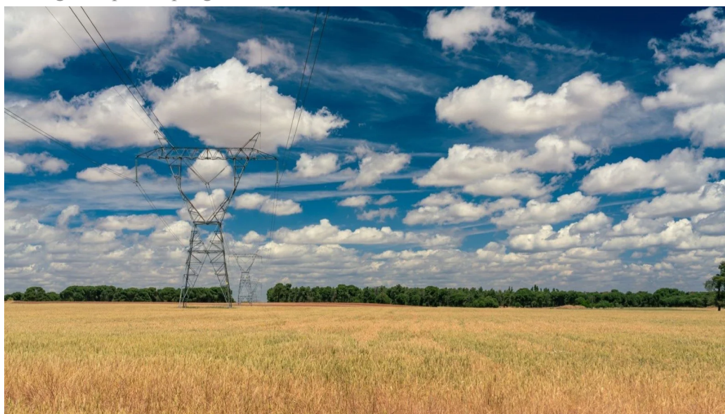
líneas eléctricas y aves
