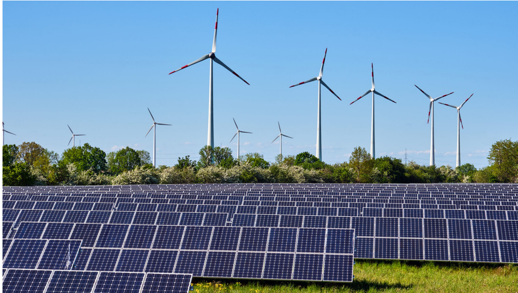
Instalaciones renovables de Qualitas Energy.
