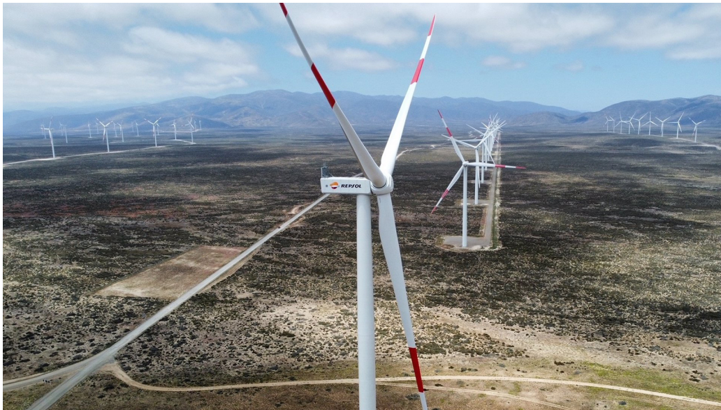
Parque eólico de Repsol e Ibereólica Renovables en Chile.
