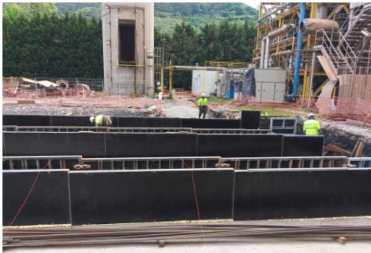
La central de biomasa de La Pereda avanza con los primeros trabajos de construcción
