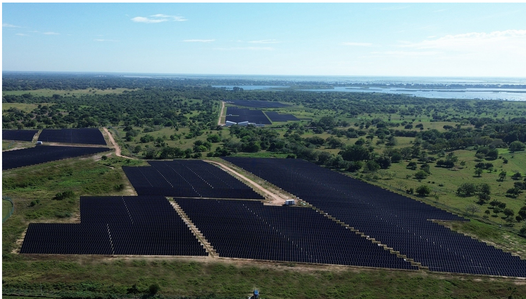
Ecoener alcanza los 680 MW en operación tras conectar dos nuevas plantas en Colombia.
