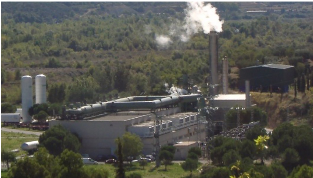
Planta de cogeneración de Neoelectra.
