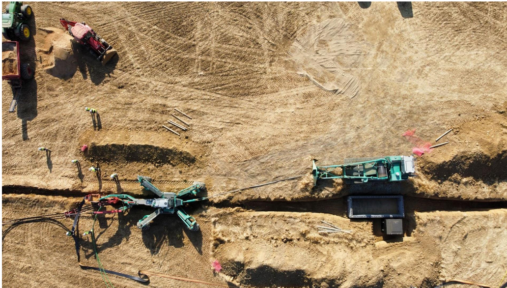
EDP ofrece soluciones de subestaciones y líneas eléctricas para clientes industriales y renovables en España.
