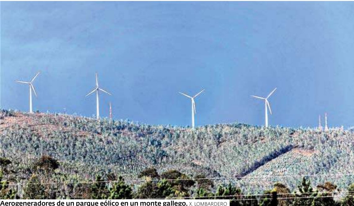
Aerogeneradores de un parque eólico en un monte gallego. X. LOMBARDEO
