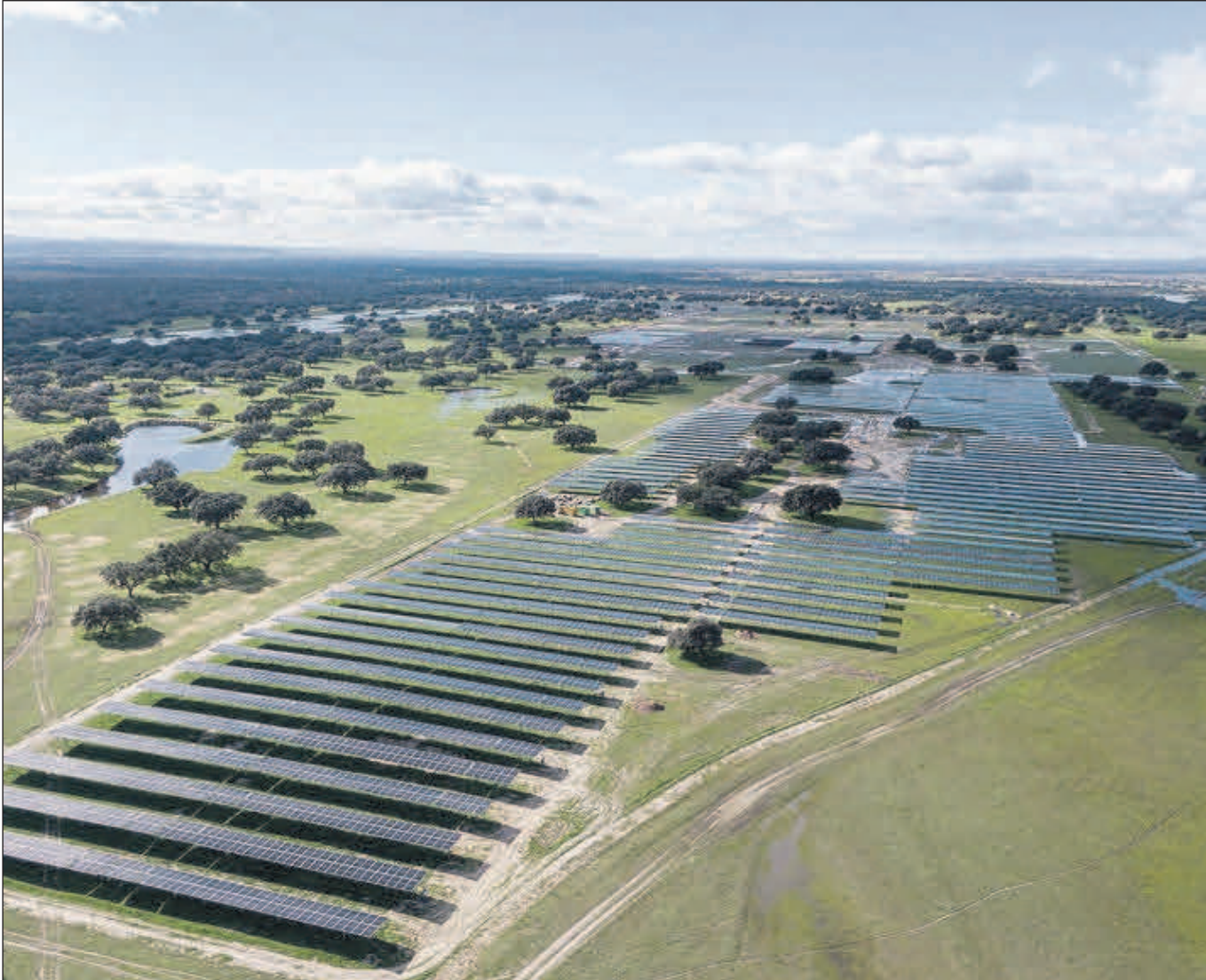
Planta fotovoltaica. EP
