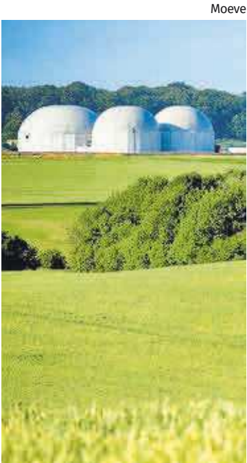
Instalaciones de Moeve.
