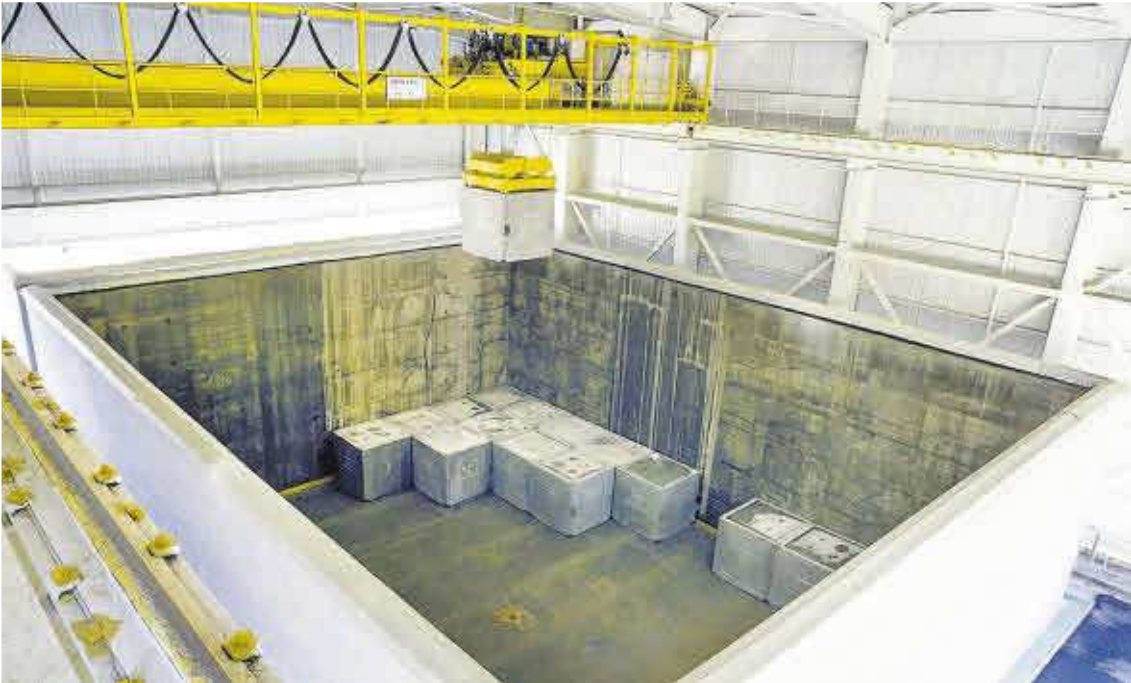
El Cabril, cementerio nuclear de residuos de baja y media intensidad ubicado en en Hornachuelos, Córdoba.
