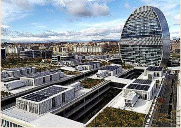
Impulsa la eficiencia energética en los edificios.
