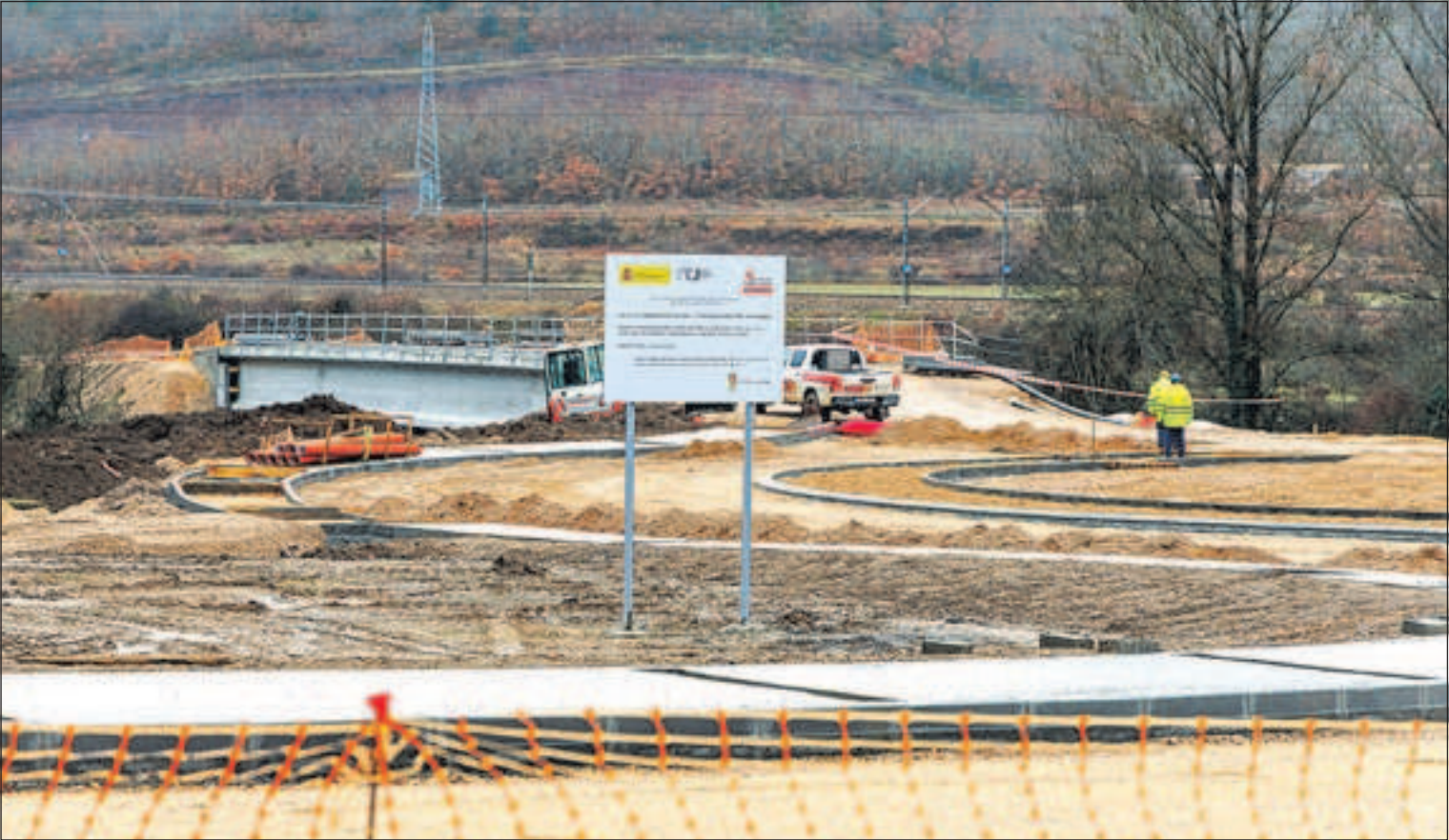
Obras en el polígono de La Robla donde se ubicará el proyecto de hidrógeno La Robla Green. VIRGINIA MORÁN
