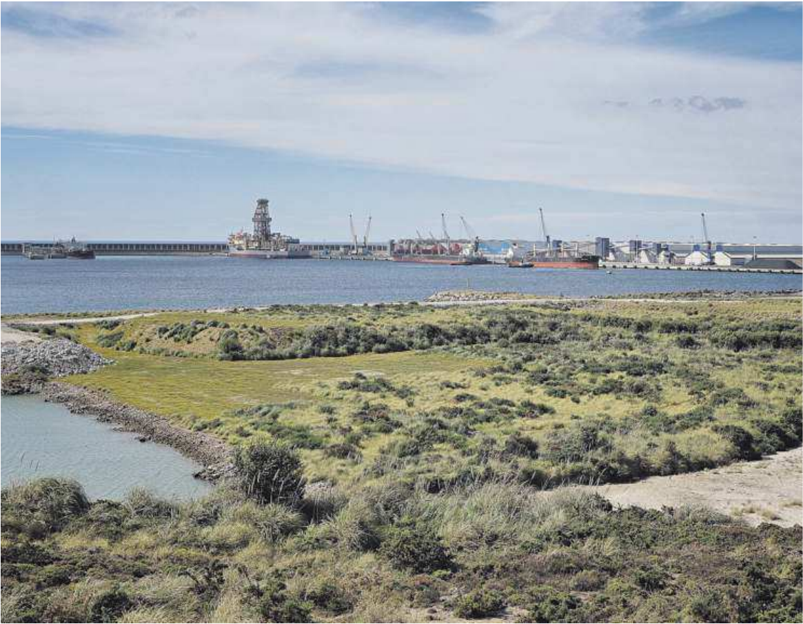
En primer término, zona en la que se implantarán las empresas dedicadas a los componentes de energía eólica marina y en la que se hará un nuevo muelle
