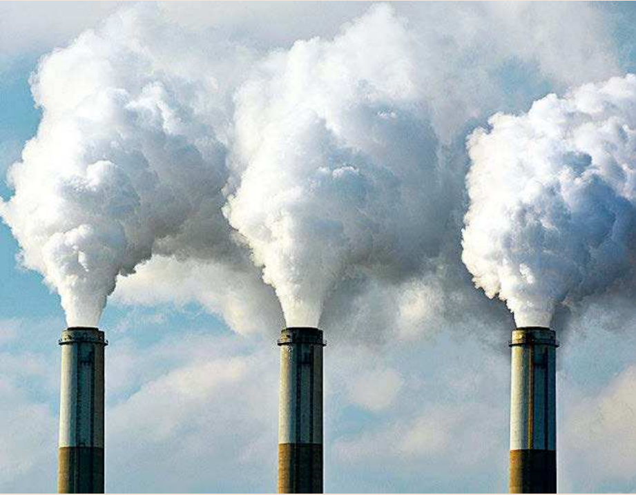
10.000 instalaciones industriales europeas podrían beneficiarse de la modificación.
