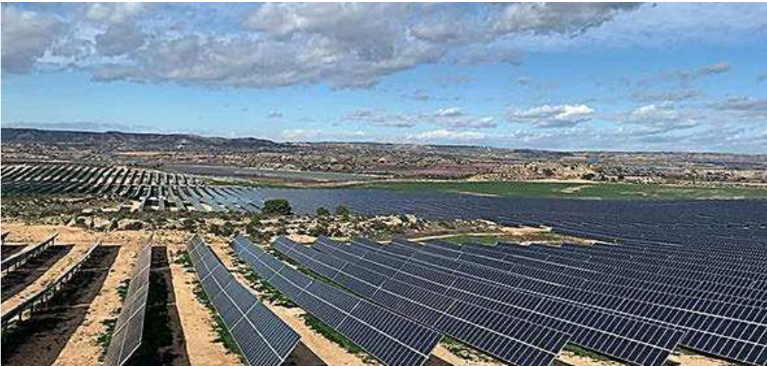
Una planta solar. eE
