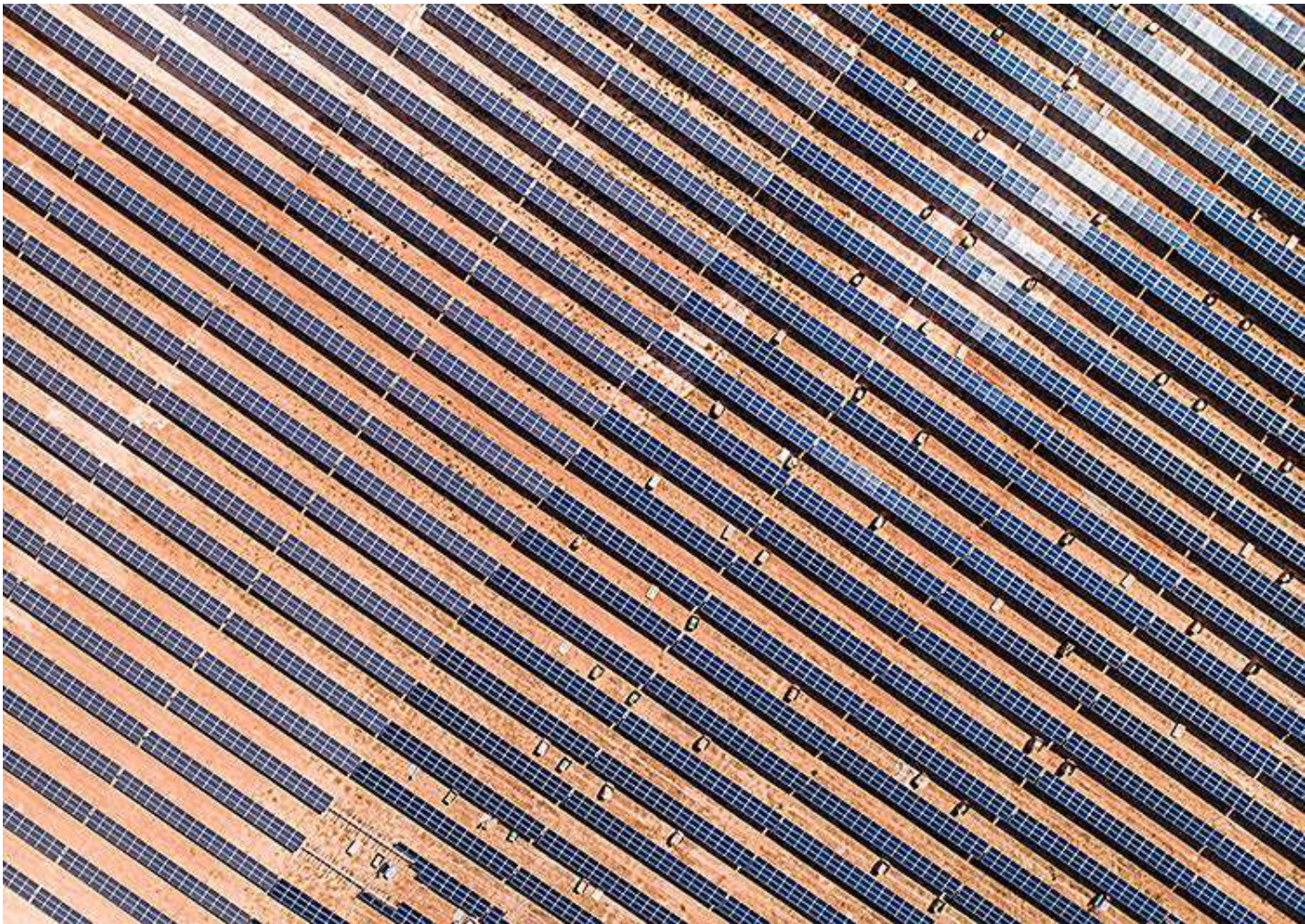
Una planta solar. eE
