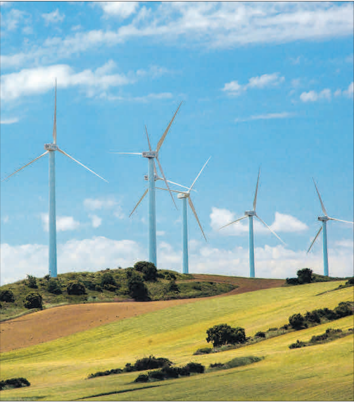
Un parque eólico. CORDON
