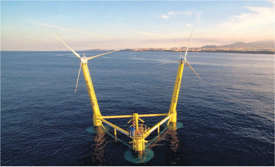
PROTOTIPO REALIZADO A ESCALA DE LA TECNOLOGÍA W2Power EN EL BANCO DE ENSAYOS DE PLOCAN, EN GRAN CANARIA. DA
