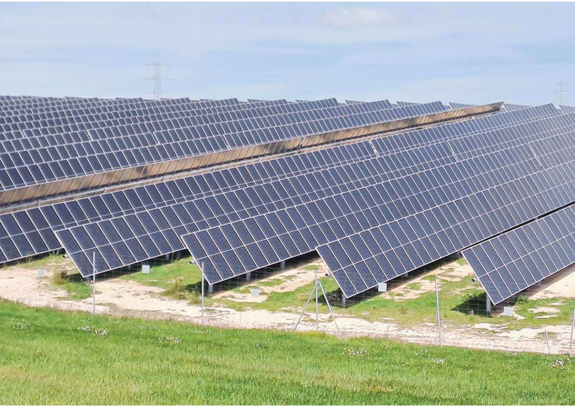
Paneles solares en el Ventorrillo, entre los cascos urbanos de Andorra y Albalate. M. N.
