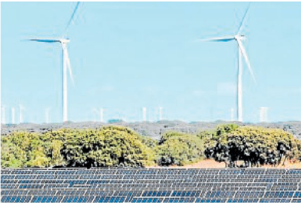
Fotovoltaica integrada en el medio rural A la izquierda, en la página anterior, una planta fotovoltaica en Almaraz (Cáceres) y, derecha, el Huerto Tornasol de Albacete
