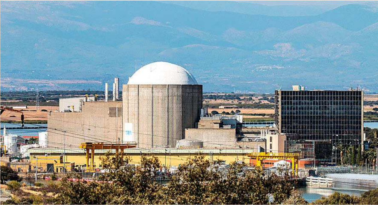
Central nuclear de Almaraz, en Cáceres (Extremadura).
