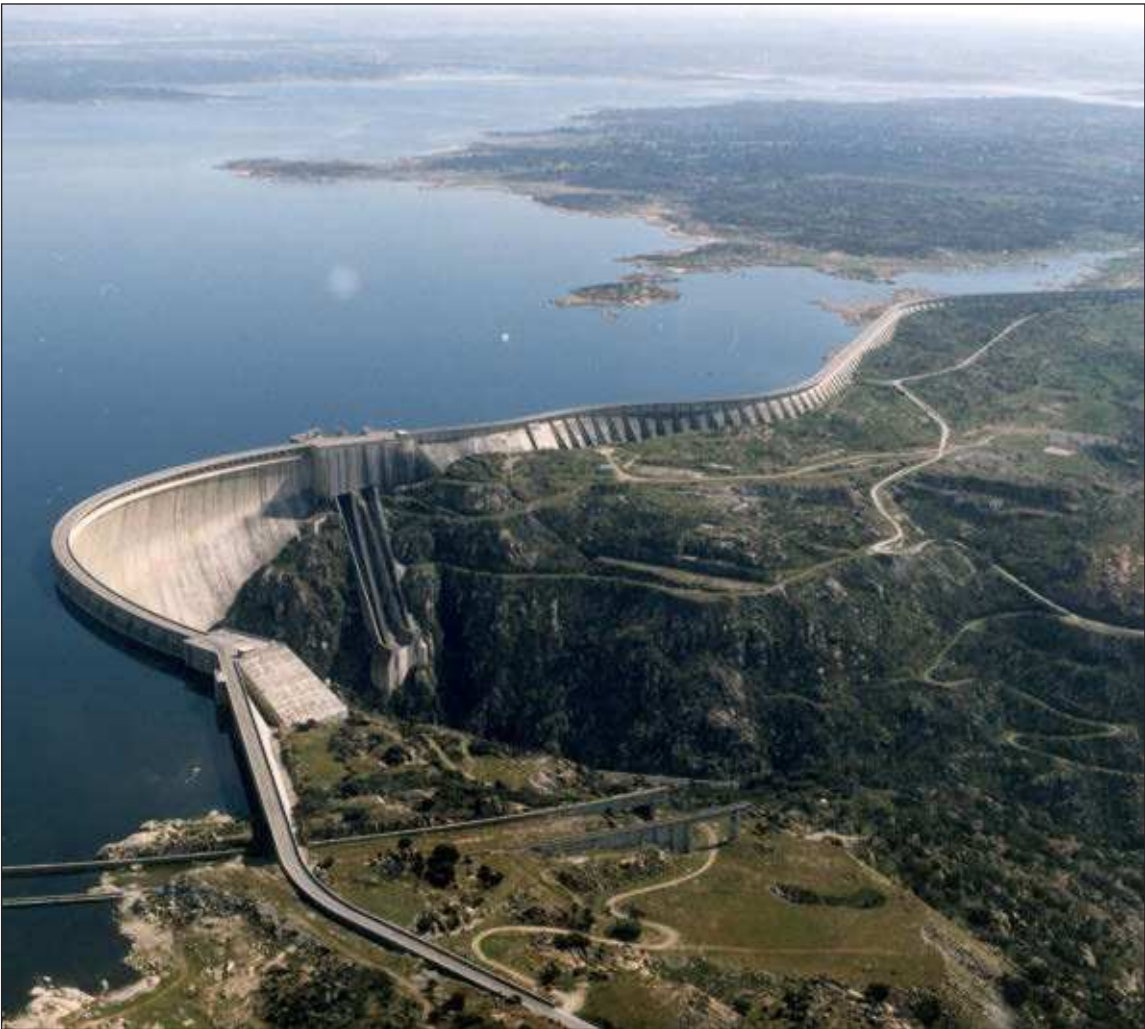
Una planta hidroeléctrica. EE
