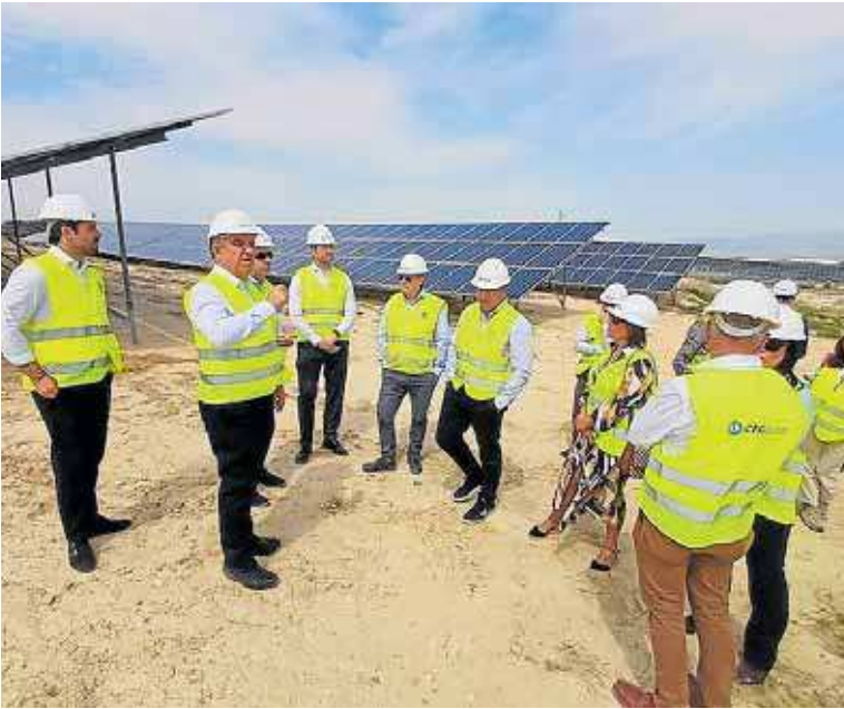
Planta fotovoltaica instalada en Mula. CARM
