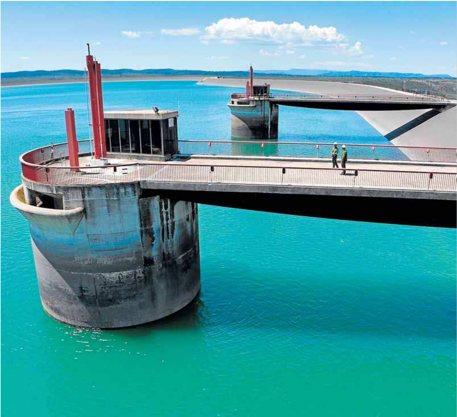
Depósito superior del aprovechamiento hidroeléctrico Cortes-La Muela. LP
