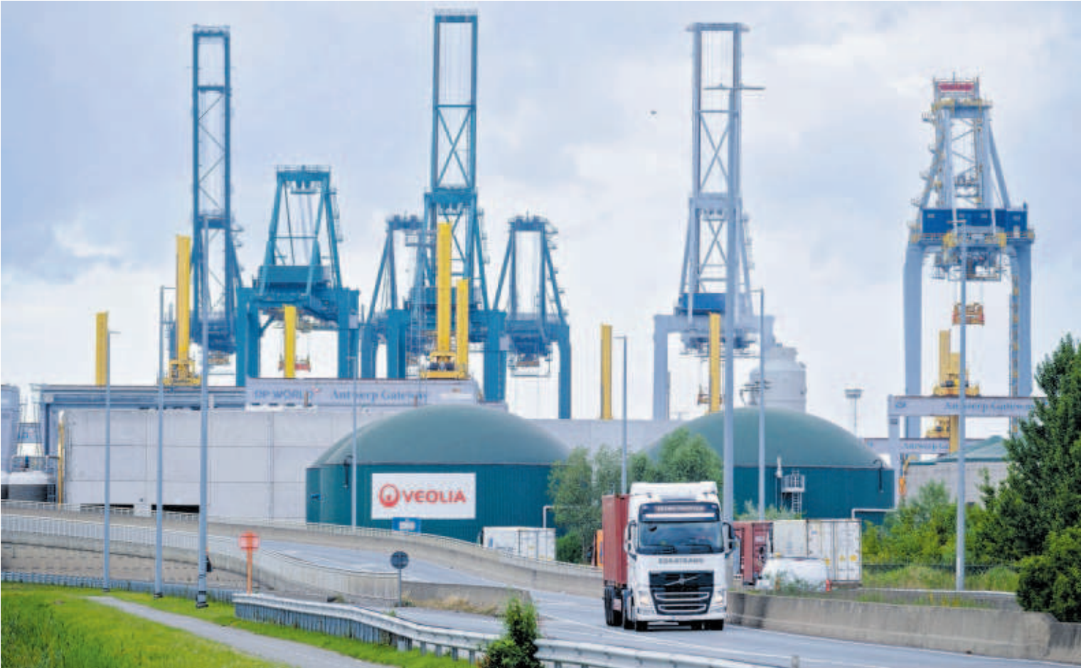
Instalación de Veolia en el puerto de Amberes (Bélgica). THIERRY MONASSE (GETTY)
