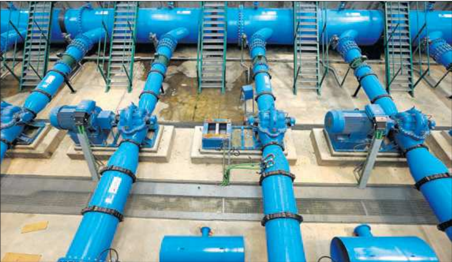
Quando se necesita energía, el agua desciende y mueve las turbinas para volver a generar electricidad. JESÚS F. SALVADORES
