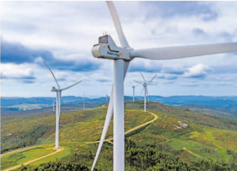
Parque de turbinas aéreas. PABLO CANDAMIO
