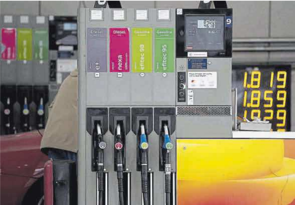
Surtidores en una gasolinera de Madrid.
