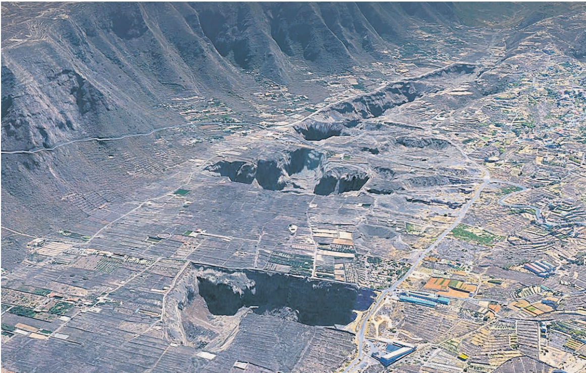
LA INSTALACIÓN SE UBICARÁ EN LOS BARRANCOS DE GÜÍMAR, SOBRE UN SUELO DEGRADADO POR LA EXTRACCIÓN DE ÁRIDOS. DA
