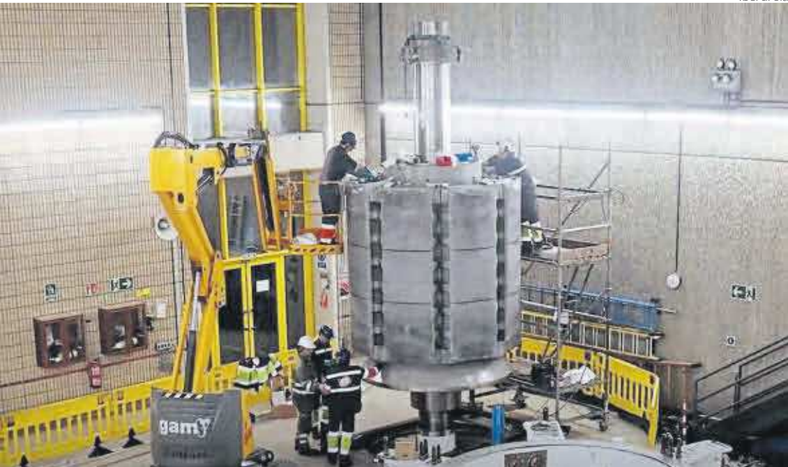
Trabajos de rehabilitación en la central Soutelo, una de las que integra el aprovechamiento de Bibey.
