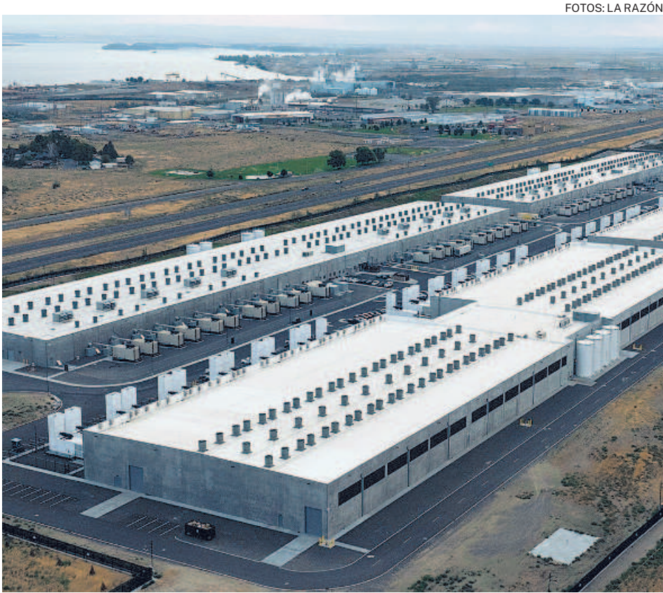
El data center requiere de energía que garantice su continuidad operativa 24x7
