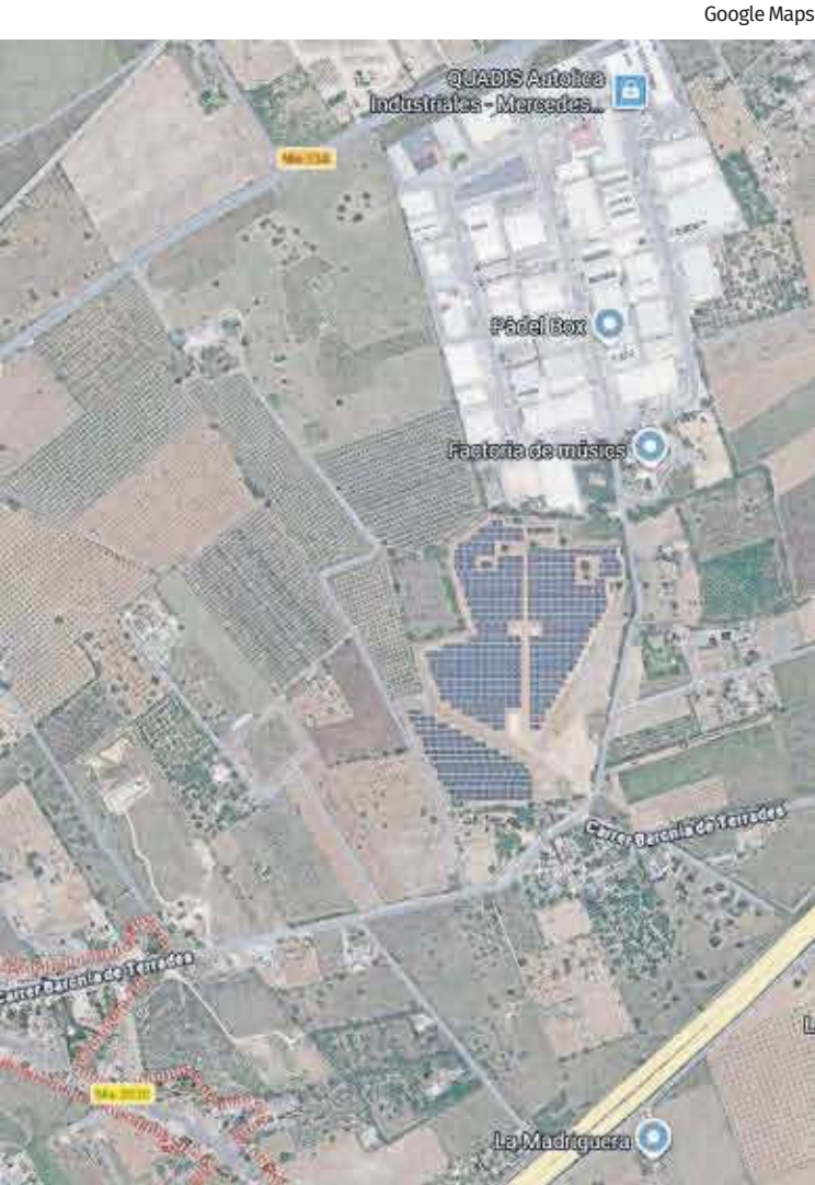
El parque fotovoltaico junto al que se quiere habilitar la planta.
