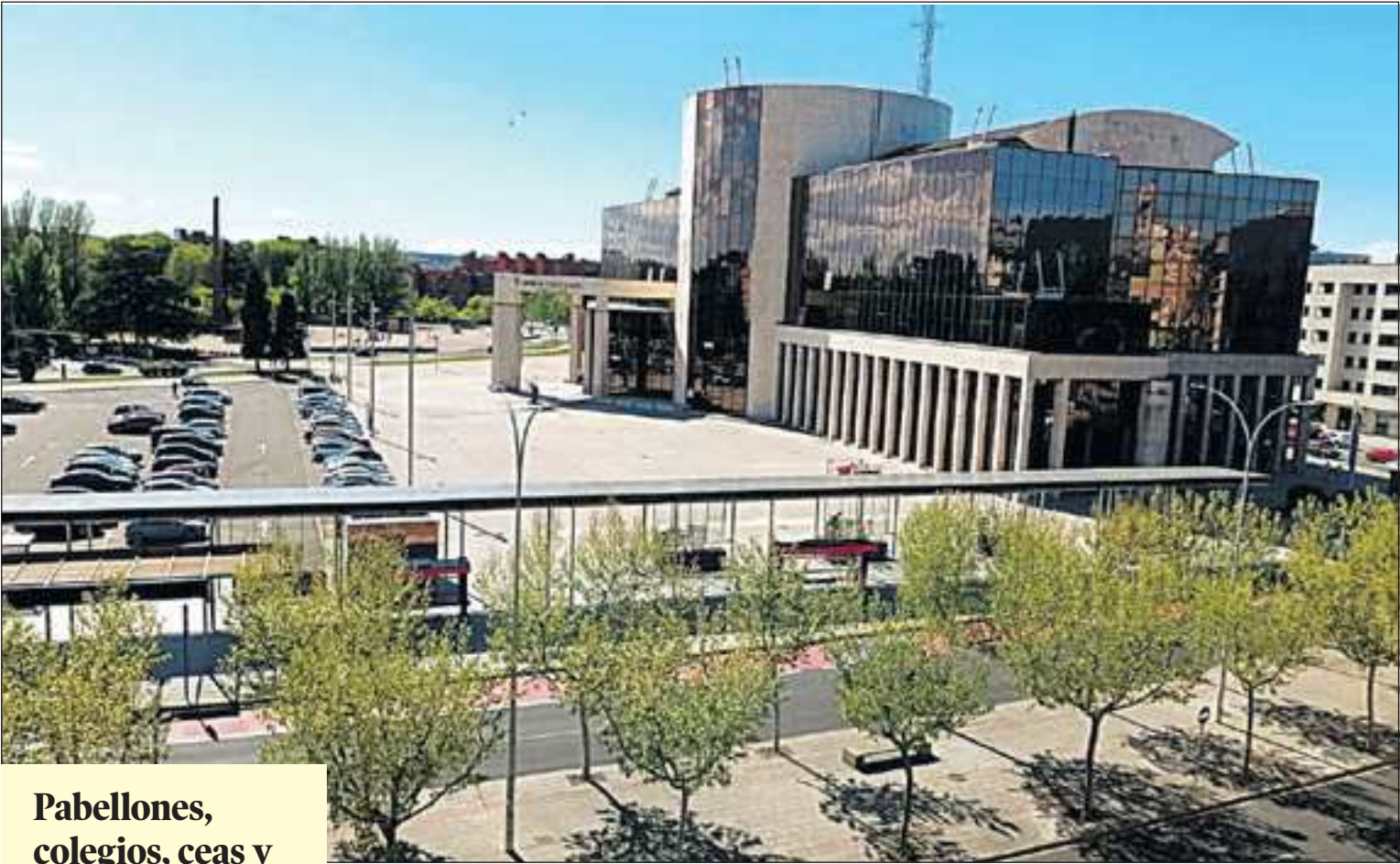
La pérgola de Reyes Leoneses es uno de los equipamientos con paneles solares. CDLR
