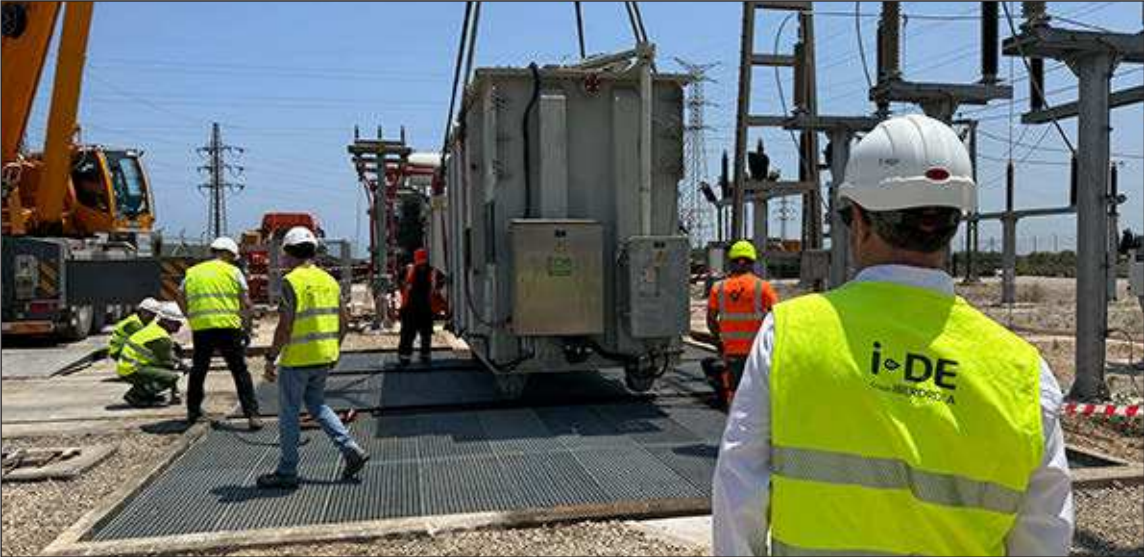
Trabajos de renovación en la subestación de Silla, llevados a cabo por técnicos de i-DE (Iberdrola). EE
