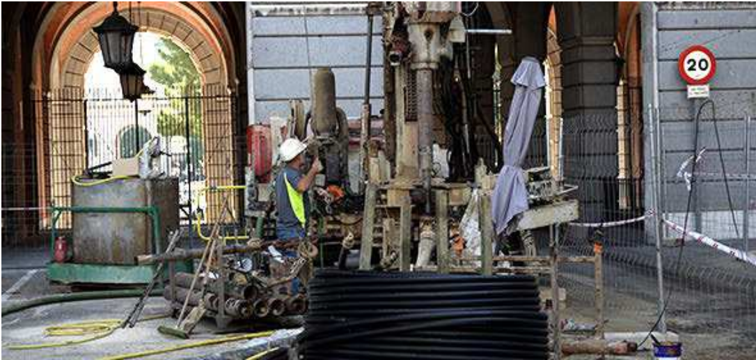
Obras de geotermia.
